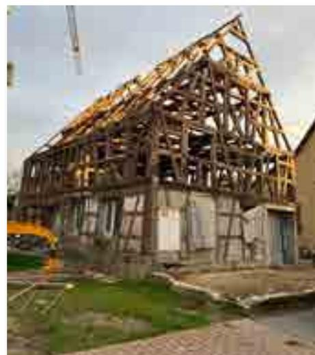
L'architecture traditionnelle sera restaurée (fenêtres et volets en bois, tuiles de récupération «biberschwanz», etc.) et des matériaux naturels et biosourcés seront utilisés (enduits à la chaux, blocs de chanvre, laine de bois, etc.).
