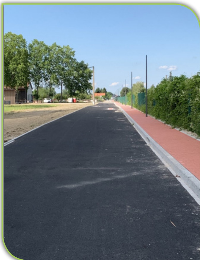
Après les travaux
