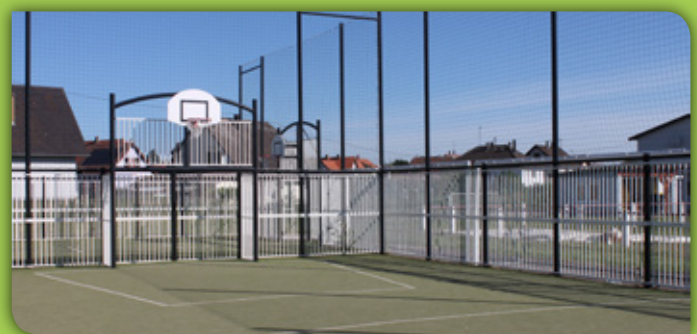
City stade après travaux
