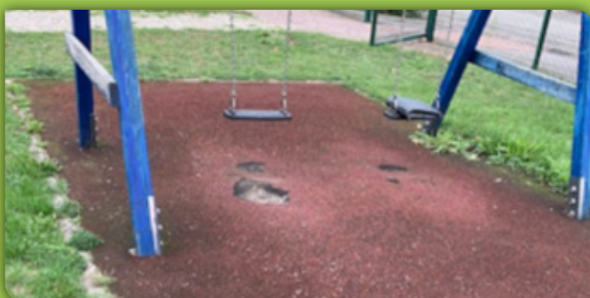
Aire de jeux avant travaux
