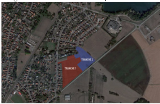
Photo aérienne du périmètre de projet lotissement « Feldlach »
