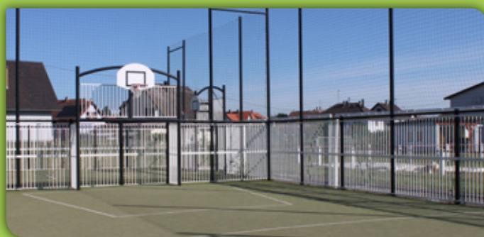
City stade après travaux
