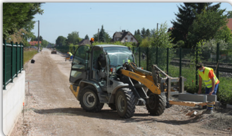
Pendant les travaux
