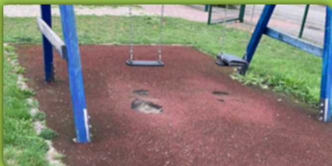
Aire de jeux avant travaux
