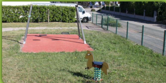
Aire de jeux après travaux
